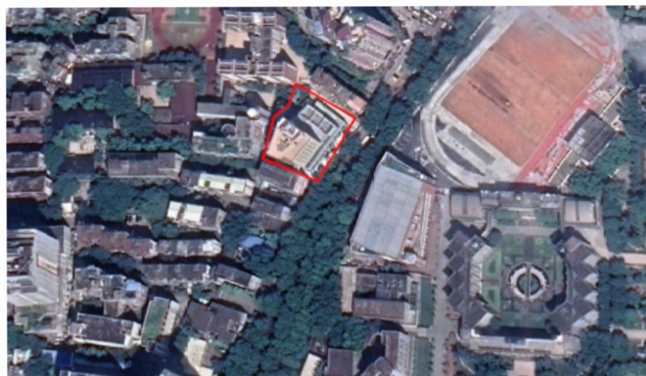
施工后（2018年10月29日）
